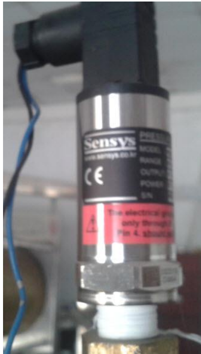
Hình 7.26 Cảm biến áp suất
